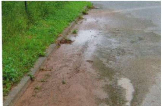
....of in de riolering van de weg.
