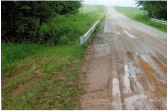
....in de berm....
